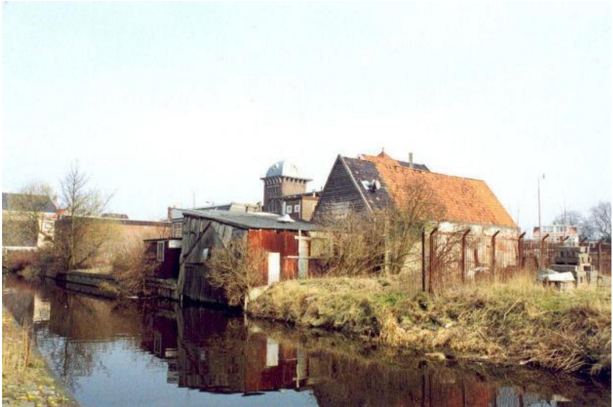
De Potmarge, in 1993 gezien naar naar het noorden.
